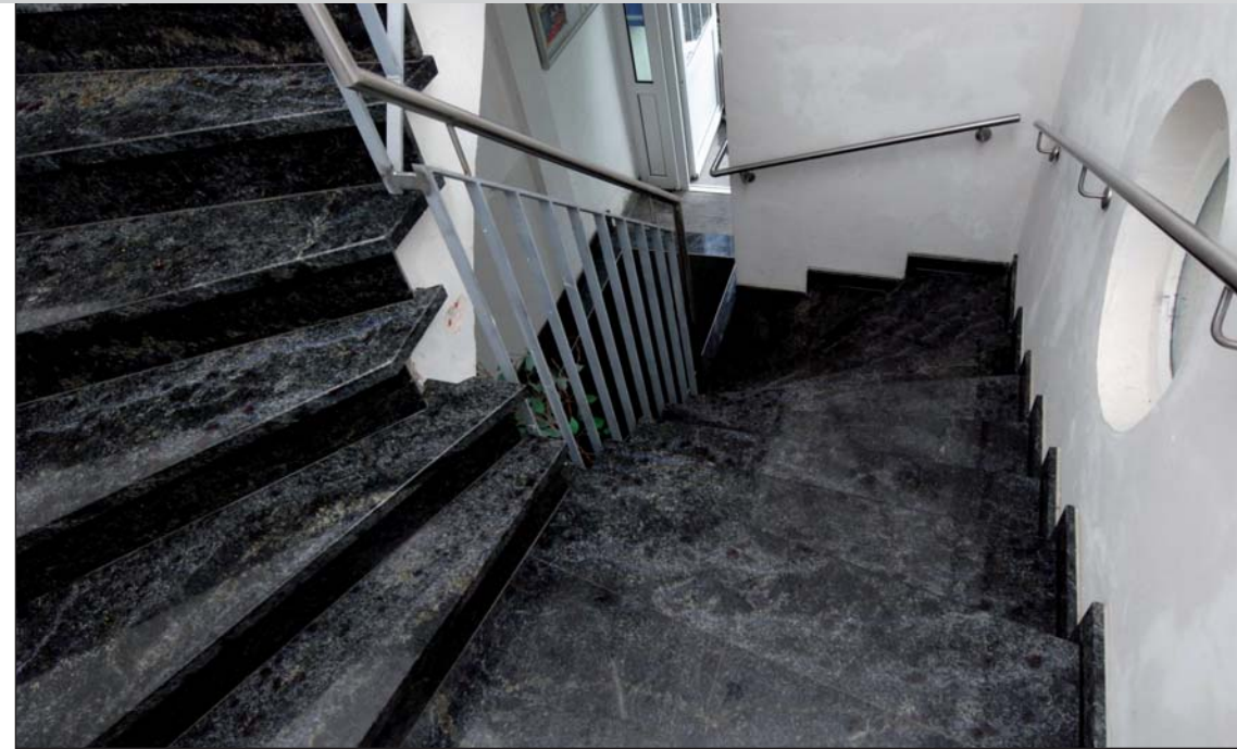
Moderner Look: neue Stufen und neues Geländer. Die restliche Renovierungsarbeiten des Treppenhauses werden auf den Winter verschoben
